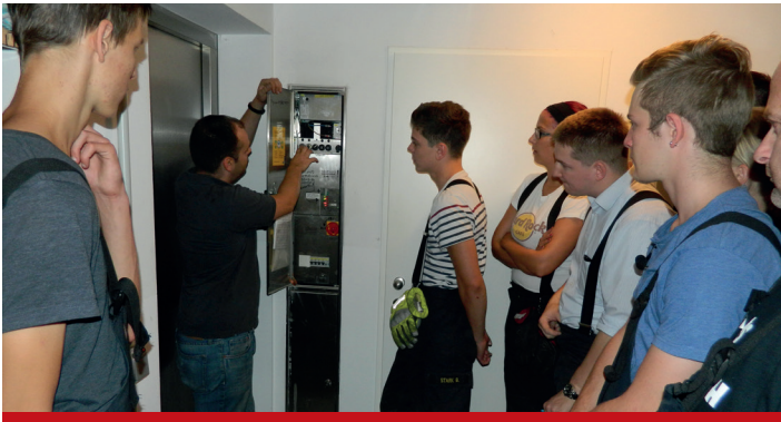
Notbedienung eines Aufzugs
